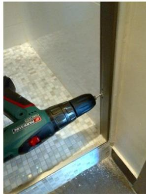
Absicherung der Befestigung des Mauerprofils durch Ansenken der gefrästen Löcher des Profils in der Mauer und Befestigung der Schrauben.
