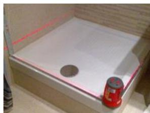
Kontrolle der einwandfreien Rechtwinkligkeit nach dem Verleimen der Schwellenleisten und der Mauerprofile...
