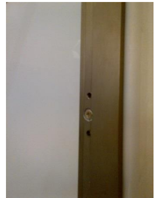
Sécurisation de la fixation du profil mural par contreperçage des trous fraisés du profil dans le mur et fixation de vis à frapper.
