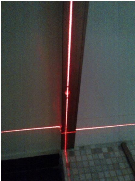
Alignement parfait du profil encollé sur la verticale tracée par le laser.
