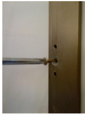
Sécurisation de la fixation du profil mural par contreperçage des trous fraisés du profil dans le mur et fixation de vis à frapper.
